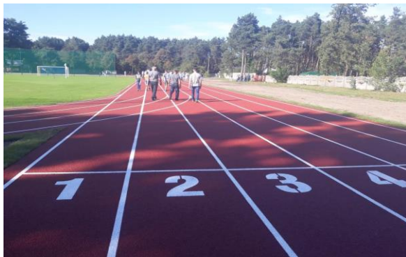
Zdjęcie 17. Boisko wielofunkcyjne w Wadlewie
