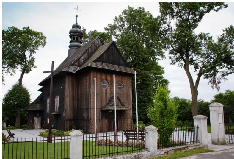
Zdjęcie 3. Kościół św. Ignacego Loyoli w Suchcicach.
